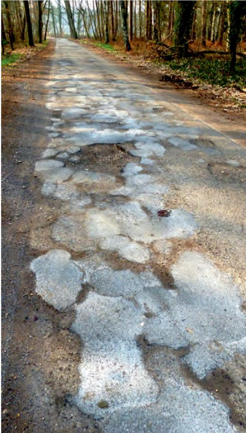
Wir sprechen hier vom Stallmannsweg, der beliebten und daher stark frequentierten Abkürzung zwischen dem östlichen Teil von Mehrhoog in und aus Richtung Bergerfurth. Die über Jahre betriebene Instandhaltungspraxis – eine Schaufel Kaltasphalt ins Loch, festgeklopft und ein wenig Sand darüber, damit der nächste Autoreifen das Loch nicht schon wiederherstellt – hat fatale Folgen. Die Schäden werden viel schneller noch größer.
